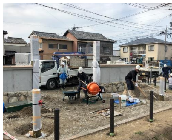
モニュメント工事の様子
